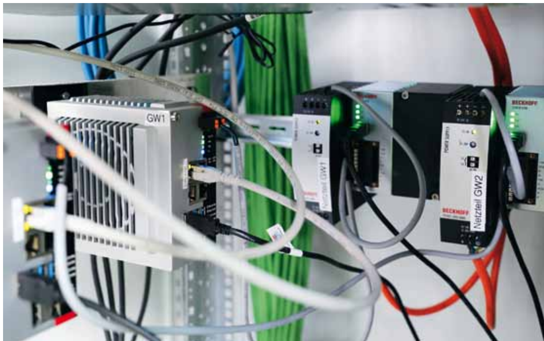
A Beckhoff PS-sorozatú tápegységeivel (jobbra) táplált, C6030-sorozatú ultra-kompakt ipari PC-k központi szerepet játszanak mint edge gateway-ek (© Beckhoff)
